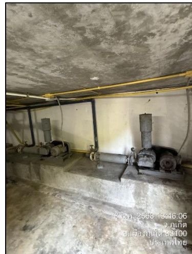
รูปภาพที่ 2.4 เครื่องเติมอากาศระบบบำบัดน้ำเสีย
