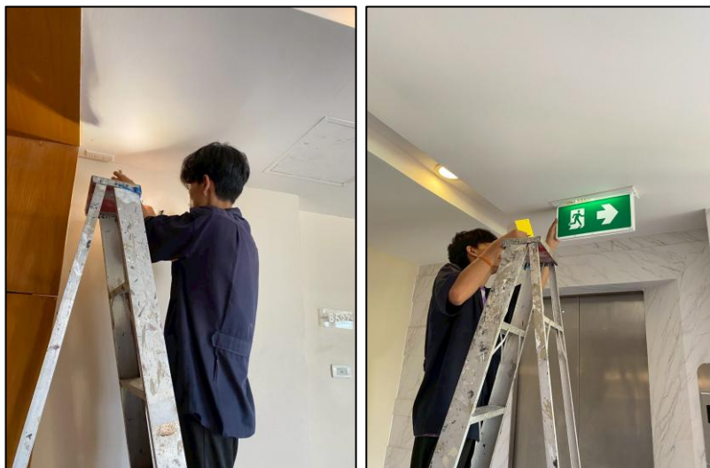
รูปภาพที่ 2.35 การตรวจสอบอุปกรณ์ป้องกันและแจ้งเตือนอัคคีภัย
